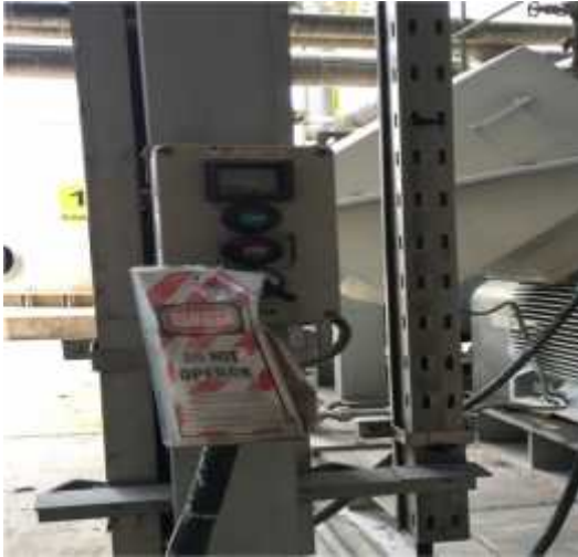
Gambar.1 Penerapan LOTO pada Panel
